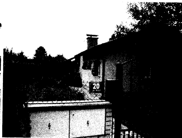
Obytný objekt č.e. 20 (výp. bod R06)
